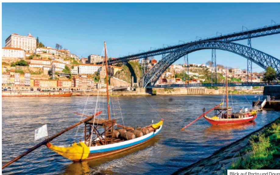
Blick auf Porto und Douro
