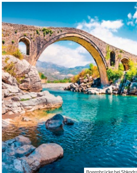
Bogenbrücke bei Shkodra
